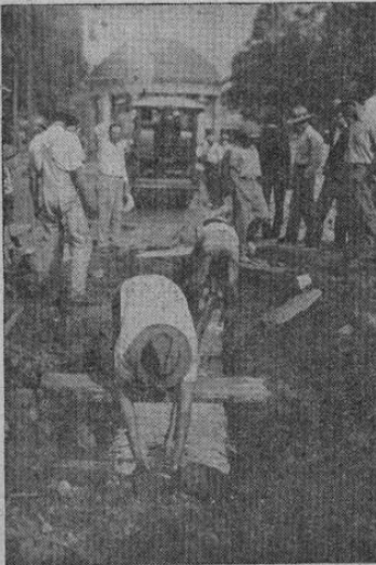
Componiendo nuestra vetusta cañería antes de proceder a la pavimentación de las calles.
